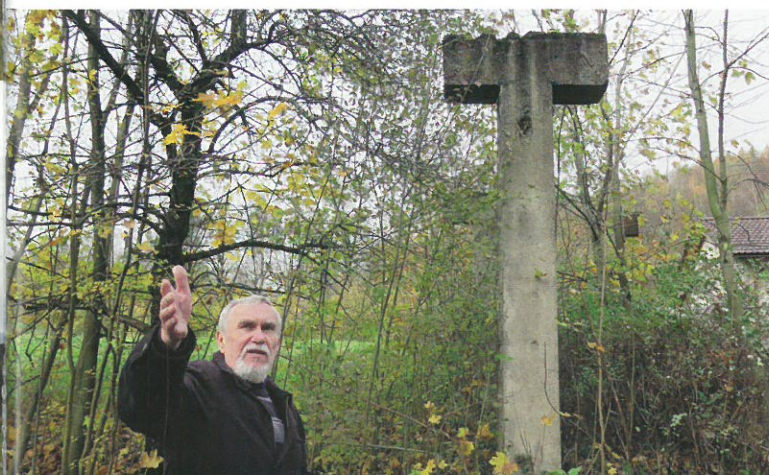
[ 43 ] Jeden z betonowych słupów będących pozostałością po rurociągu tłoczącym odpady z elektrowni przy hucie
