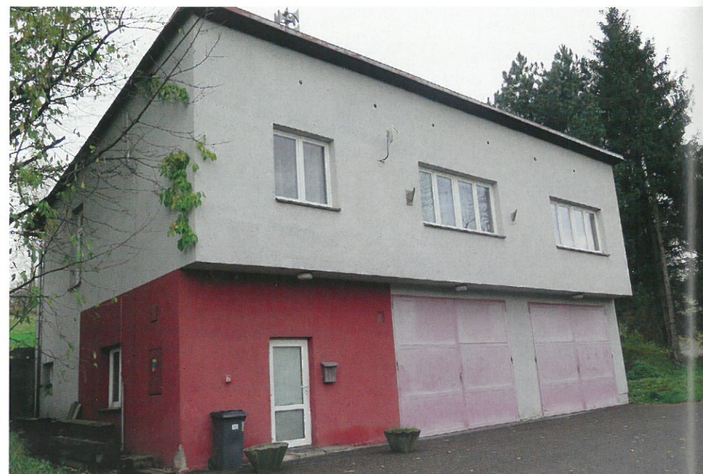
[ 27 ] Remiza straży pożarnej ▶
