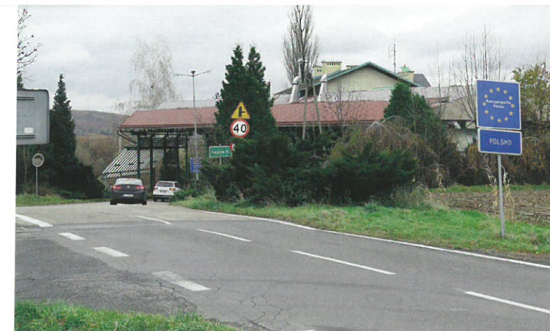
[ 55 ] Obiekt przejścia granicznego
